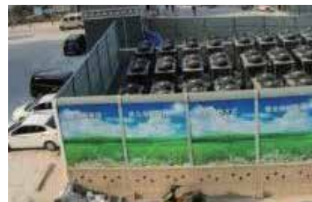
山东高墙王小区集中供暖项目
