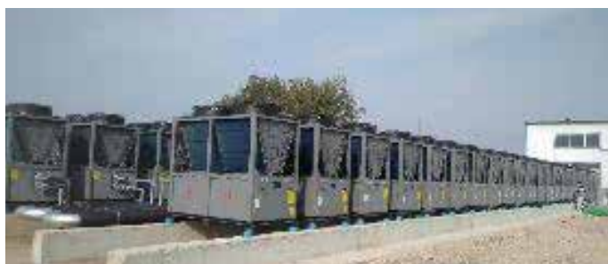
山东某小区居民楼采暖项目
