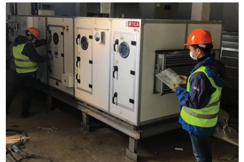
天加为雷神山现场安装医用空调设备
